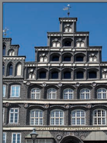
Fassadensanierung | Am Sande
